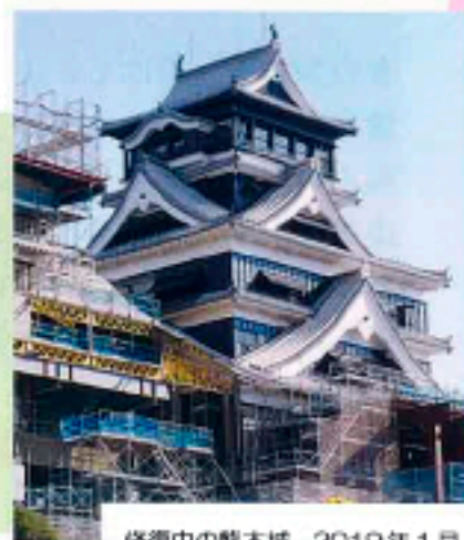
修復中の熊本城 2019年1月
